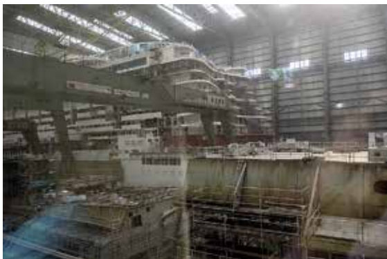
Laiva työn alla Mayerin telakalla, kuvattu lasiseinän läpi.
